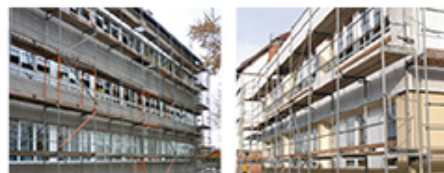
Nyílászárók cseréje és a homlokzat szigetelése
