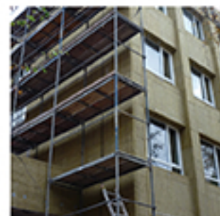
Elkészült a nyílászáró cseréje és a szigetelés
