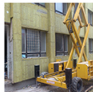
Felkerült az épületre a homlokzati szigetelés
